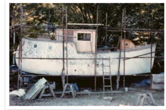
Segelboot im Bau
