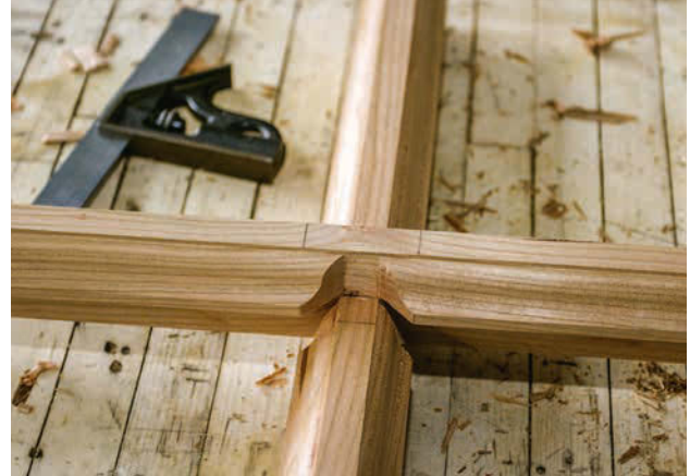
Schritt 16: Stecken Sie die Verbindung vorsichtig zusammen, kontrollieren Sie auf Rechtwinkligkeit, und prüfen Sie von oben, ob noch Material abgenommen werden muss, um eine gute Passung zu erreichen.
