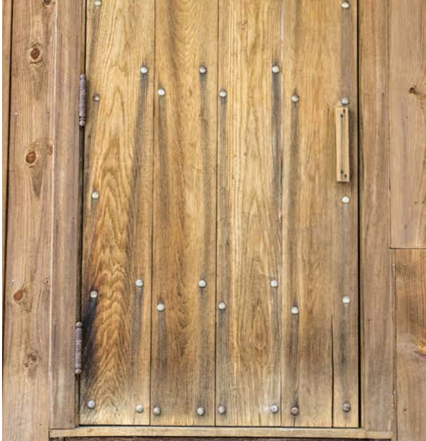
Beschläge aus Eisen und Stahl können bei Türen aus tanninreichen Hölzern wie Eiche zu Verfärbungen führen.
