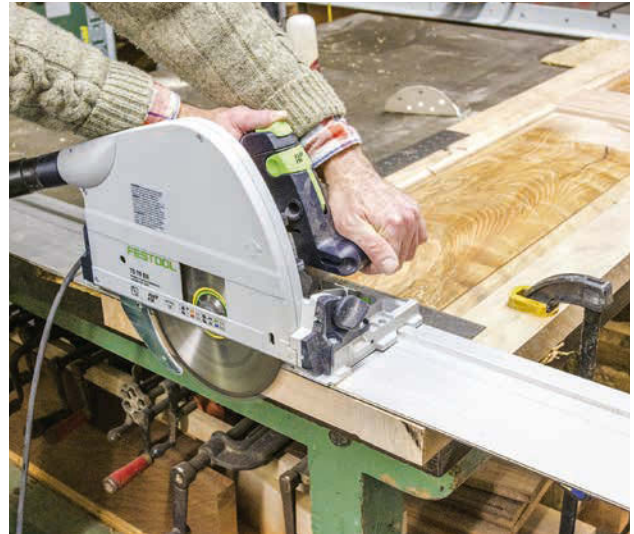
Schritt 28: Längen Sie die Tür mit der Handkreissäge und einer Führungsschiene oben und unten rechtwinklig ab.
