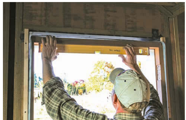
Kontrollieren Sie die obere Zarge auf waagerechten Sitz, bevor Sie die Zarge für die Schlossseite anbringen.
