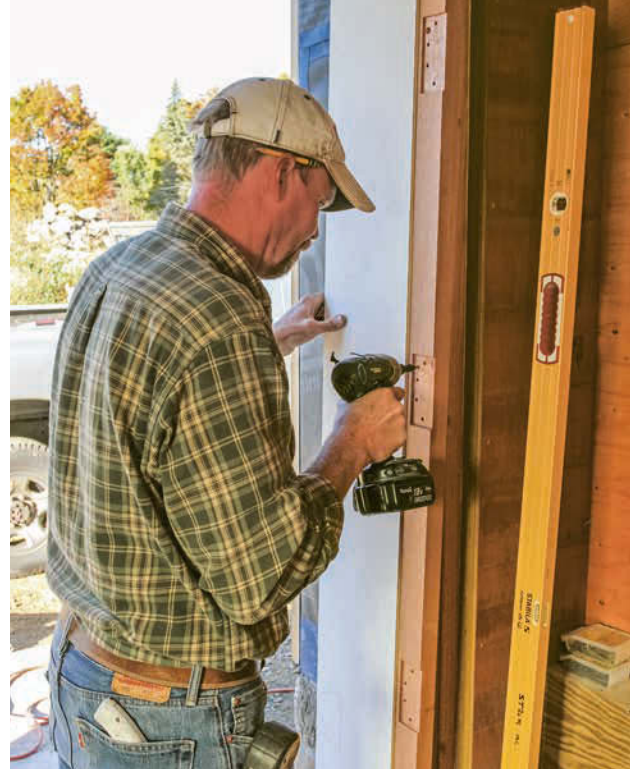
Befestigen Sie die Zarge mit langen Schrauben in den Aussparungen für die Bänder, wo sie später nicht sichtbar sind.
