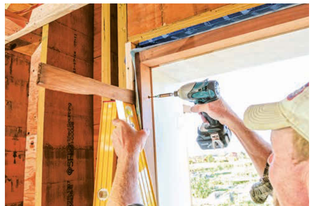
Kontrollieren Sie, dass die Schlossseite der Zarge lotrecht ist und bündig an der Wand abschließt, bevor Sie sie befestigen.
