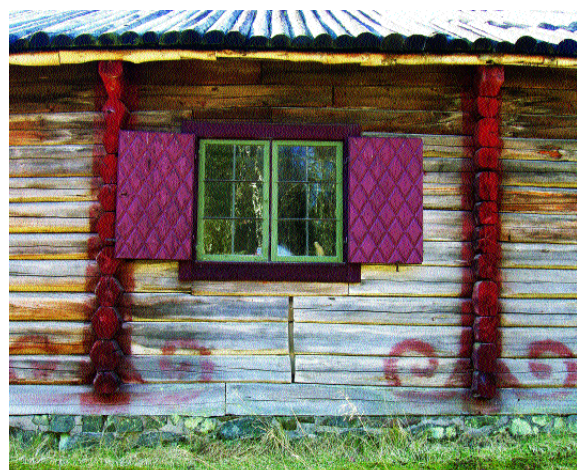
Rechts: Bei dieser „Parstuga“ aus Rättvik sieht man, wie die Balken in der Kammer zusammenge- stoßen wurden. Man erkennt auch, daß man den Balkenköpfen am neueren Teil eine andere Form gegeben hat.
