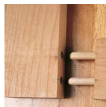
185 Gedübelte Verbindung
